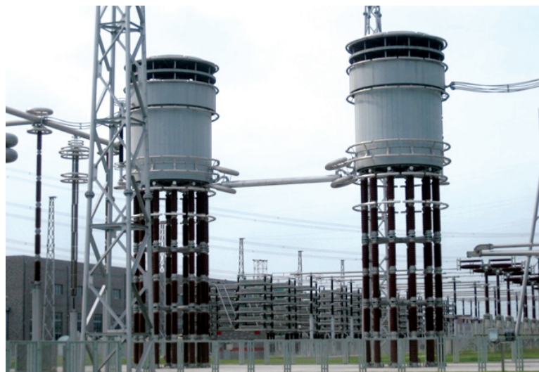
图13 北京电力设备厂生产的向家坝—上海±800kV特高压直流输电示范工程平波电抗器
