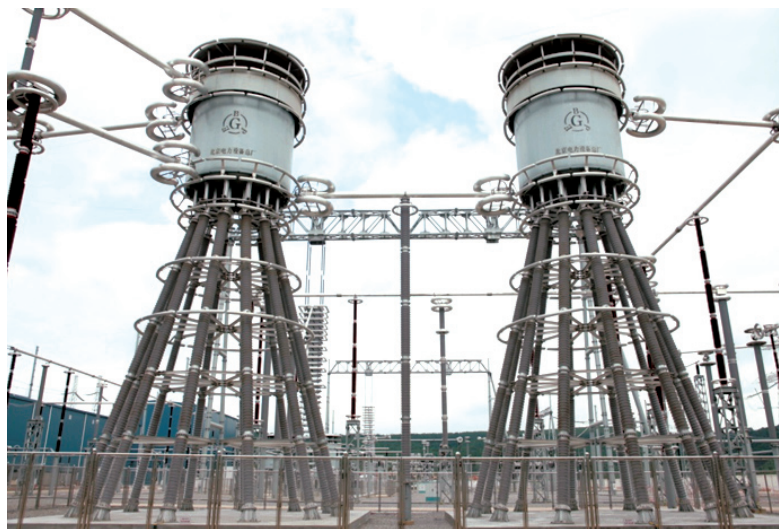
图9 北京电力设备厂生产的 \pm 800 kV云南—广东特高压直流输电示范工程平波电抗器
