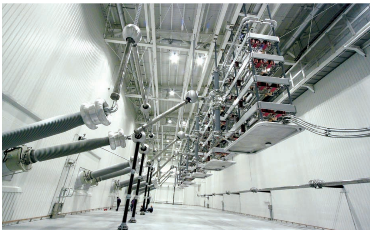
图17 西整生产的锦屏—苏南±800kV特高压直流输电工程电控换流阀
